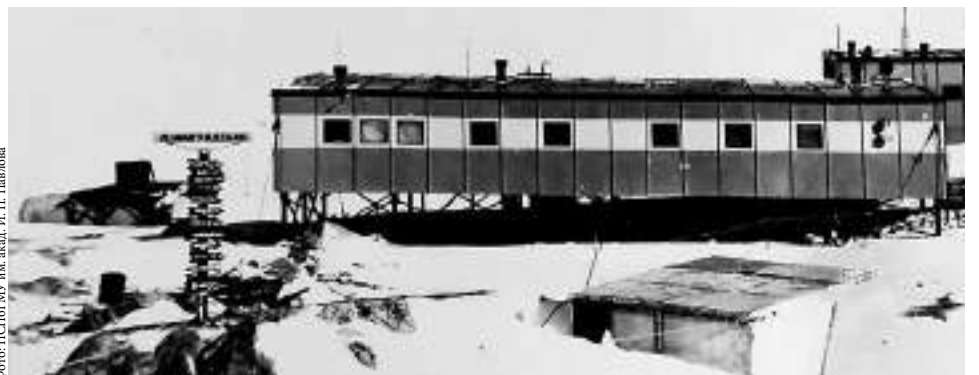
Общий вид станции «Ленинградская»
