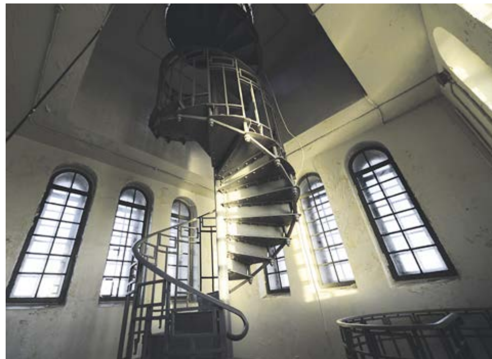
Внутреннее помещение башни Большеохтинского моста
